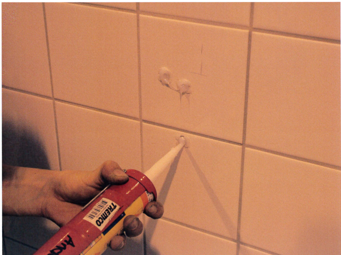
Bild 11 och 12. Vipp-plugg M6 monterade och tätning med silicon.
