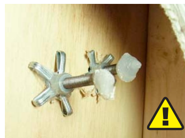
Expanderplugg deformerar väggen och skruvarna trycker med sig tätningssmassan.
