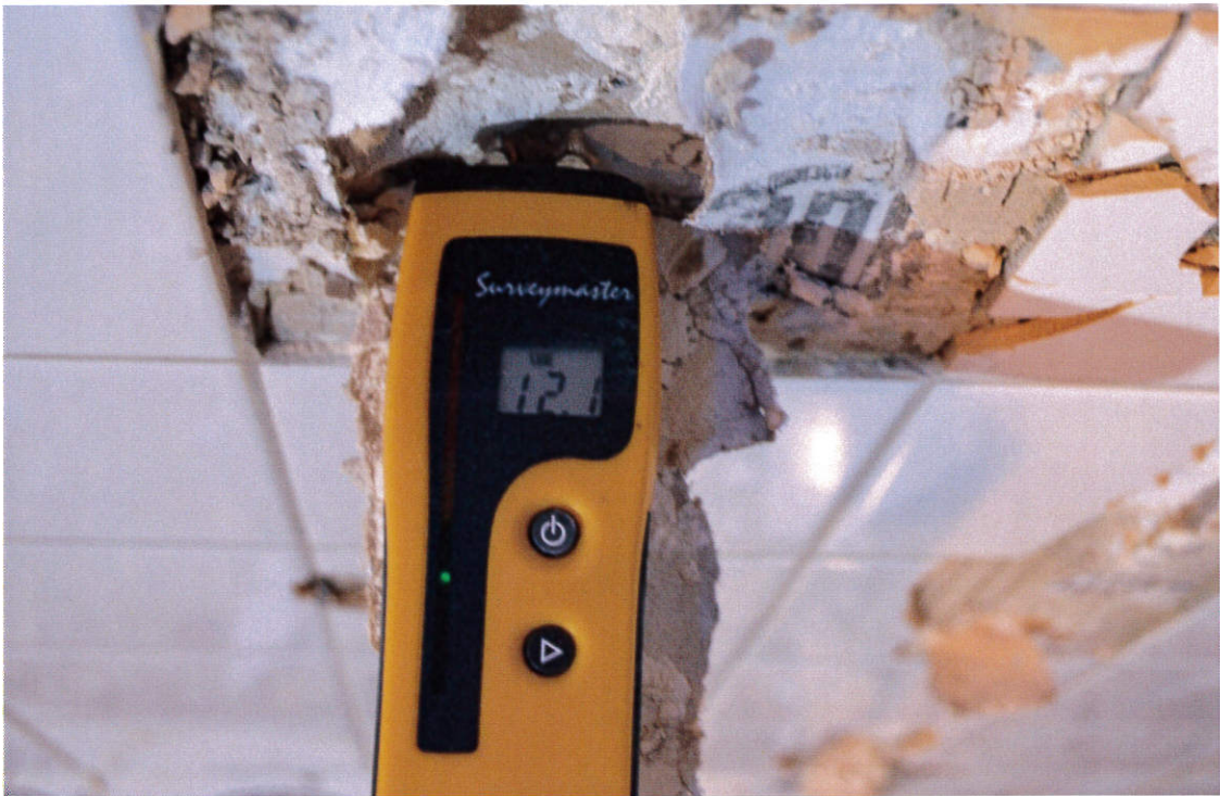
Bild 17. Kontroll av fukttinnehåll i plywood vid infästning för vägghandtag.
