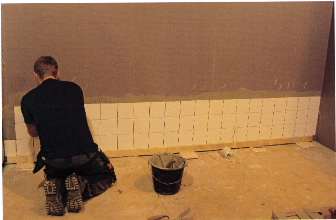
Bild 30. Montering av kakel på tätskiktet.
