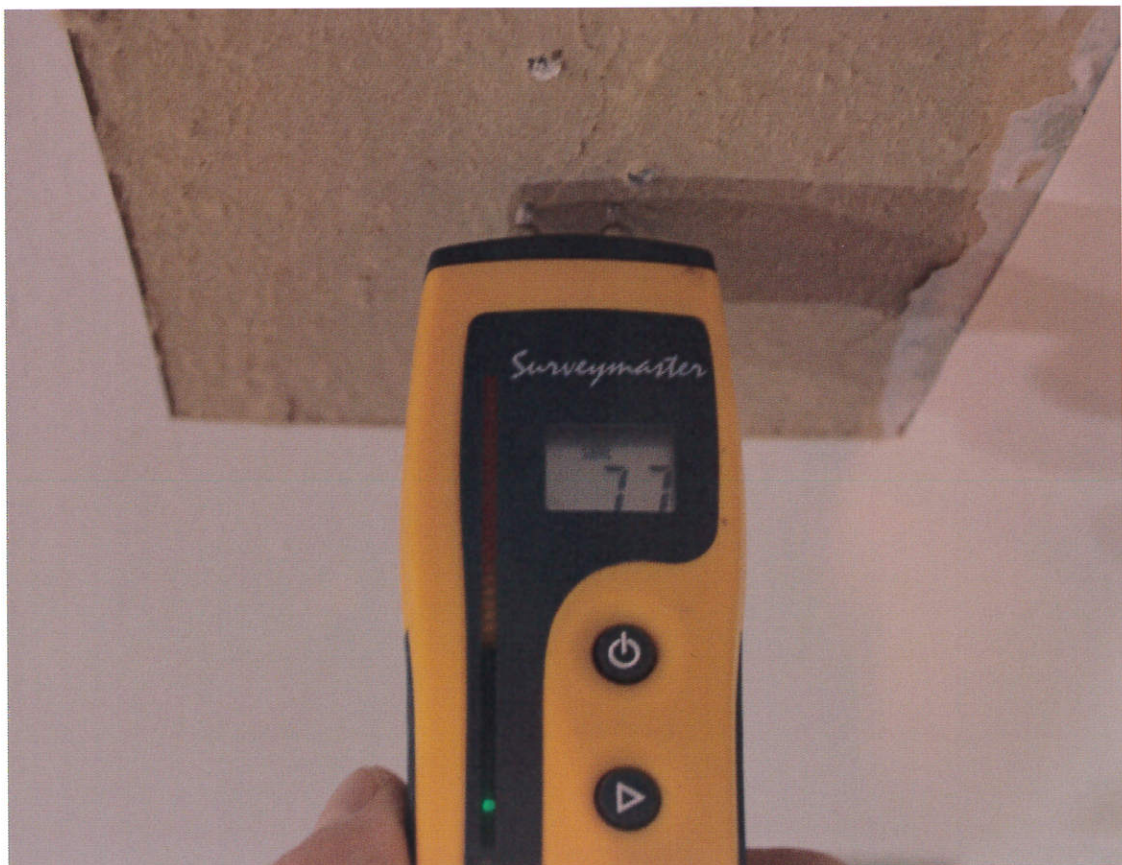
Bild 28. Kontroll av fukt vid handfatsinfästning endast infäst i plywood
