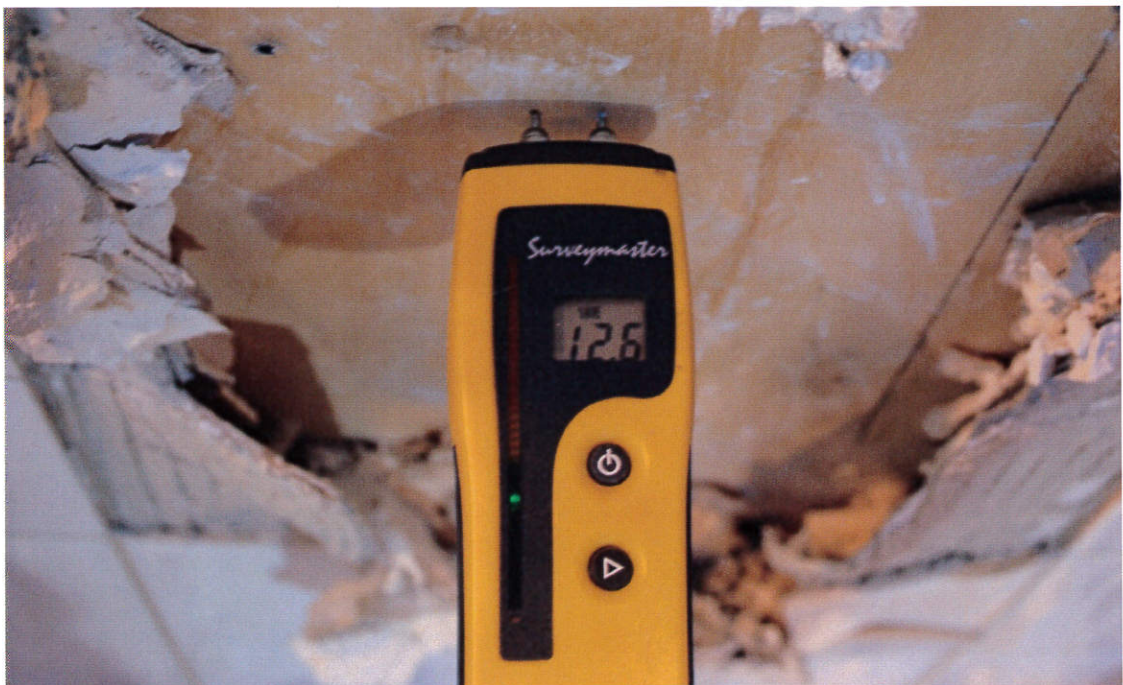
Bild 18. Kontroll av fukttinnehåll i plywood vid infästning för vägghängd duschpall.
